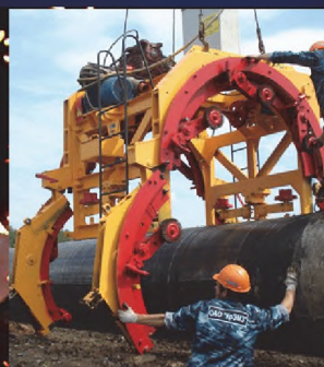
Изоляция и переизоляция труб
